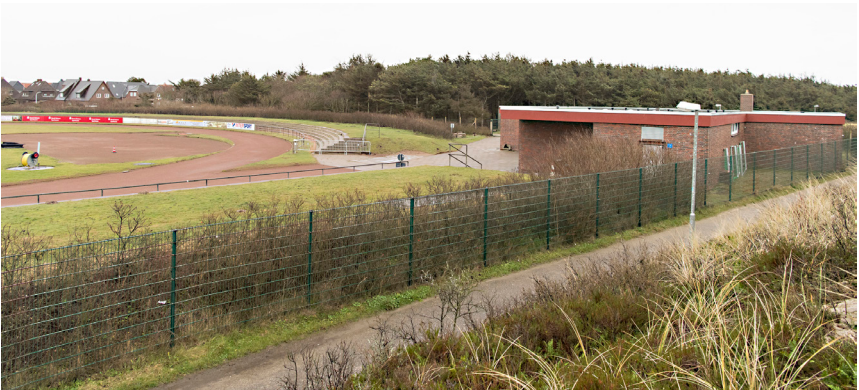
Det er på dette areal, at multiparken skal bygges. Bygningen til højre skal rives ned.
